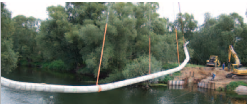
Zur Querung eines Flussbettes wird die Erdgas-Leitung in den Boden eingegraben, überdeckelt und wieder mit Aushubmaterial verkleidet – ein ökologisch quasi neutraler Ausbau des Versorgungsnetzes.
